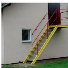
Zabezpieczenia schodów i przejść na wysokości barierkami i listwą podłogową
